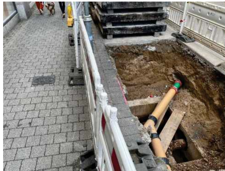
Aktuelle Bauarbeiten April 2024
